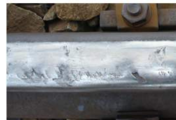
foto nr.4 - apariția fisurilor înclinate (tip head checks) linia I Km 248+080 Șina din partea dreaptă
