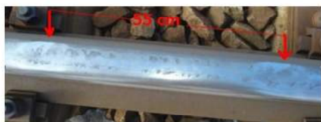
foto nr. 2- dispunerea concavităților linia II Km 248+335 Șina din partea stângă
